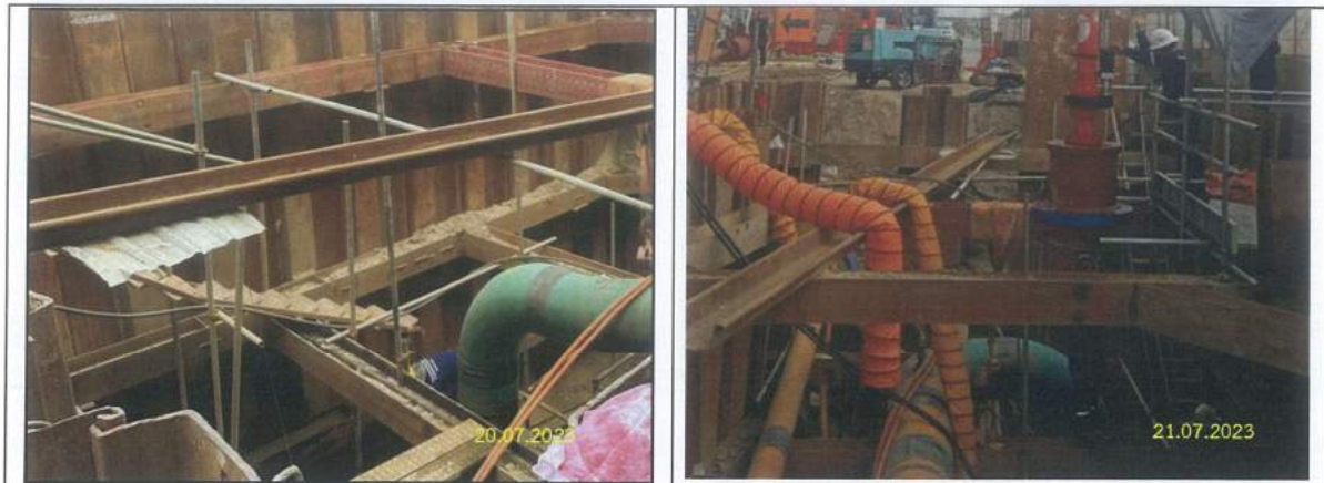
รูปที่ 2-9 การติดตั้ง Sheet Pile เพื่อป้องกันการพังทลายของดิน
