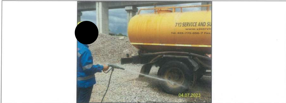
รูปที่ 2-4 การล้างทำความสะอาดเศษดิน และเศษโคลนที่ติดกับล้อรถก่อนออกจากบริเวณพื้นที่ก่อสร้าง
