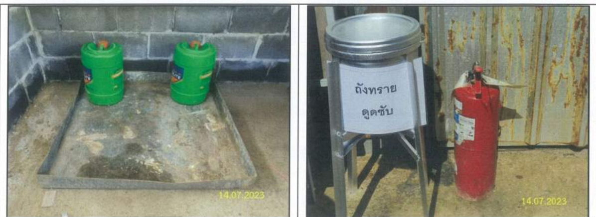
รูปที่ 2-14 การจัดเตรียมภาคเก็บรองรับน้ำมัน และวัสดุดูดซับ
