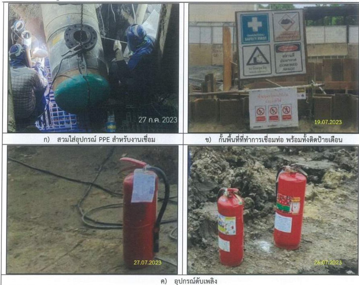
รูปที่ 2-28 การปฏิบัติด้านสาธารณสุข สุขภาพ อาชีวอนามัย และความปลอดภัย การป้องกันและแก้ไขผลกระทบช่วงงานเชื่อมท่อส่งก๊าซธรรมชาติ
